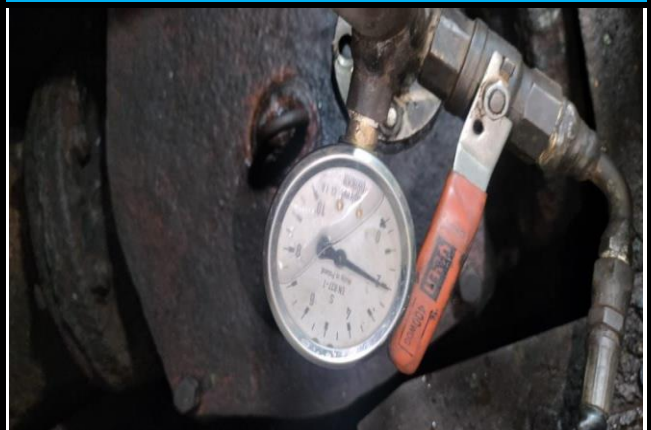
Kondisi saat dilakukan pekerjaan
