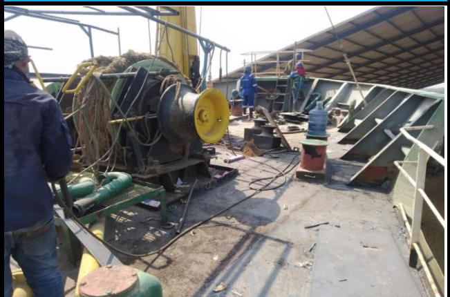
Kondisi setelah dilakukan pekerjaan
