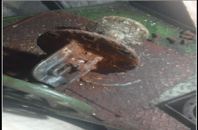
Kondisi saat dilakukan pekerjaan
