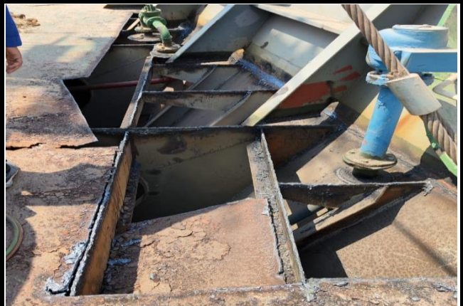
Kondisi saat dilakukan pekerjaan
