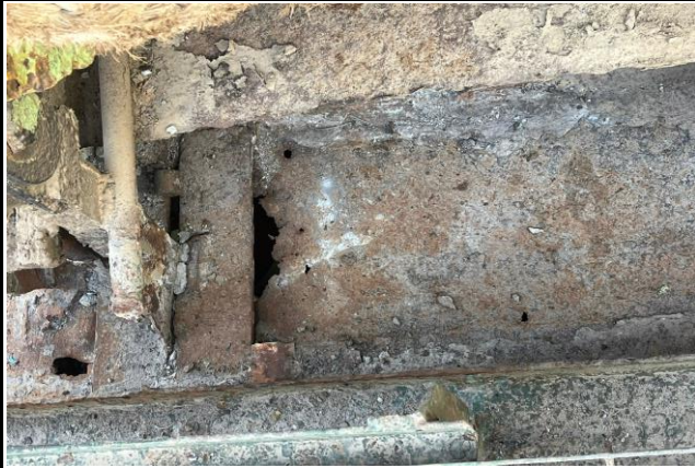
Kondisi sebelum dilakukan pekerjaan
