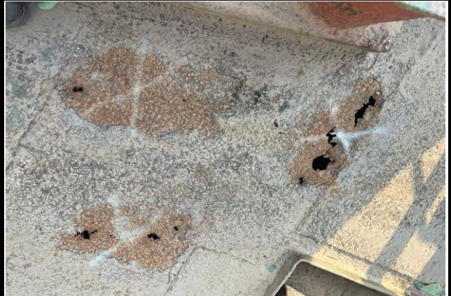
Kondisi sebelum dilakukan pekerjaan
