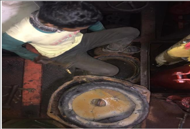
Kondisi saat dilakukan pekerjaan
