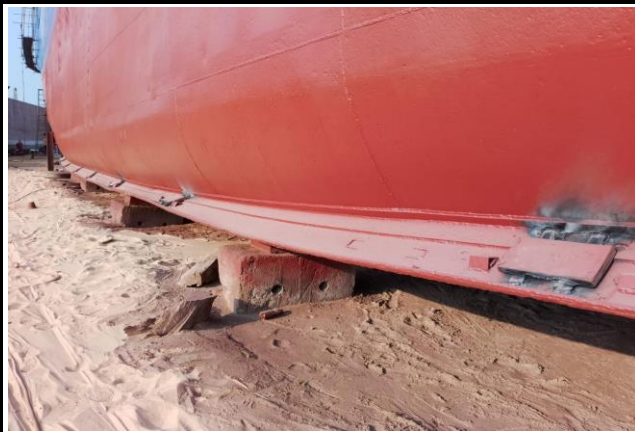
Kondisi saat dilakukan pekerjaan
