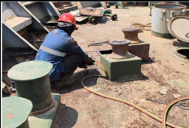
Kondisi saat dilakukan pekerjaan
