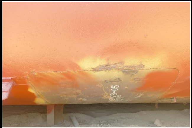
Kondisi saat dilakukan pekerjaan
