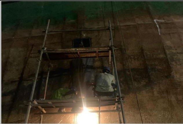
Kondisi sebelum dilakukan pekerjaan
