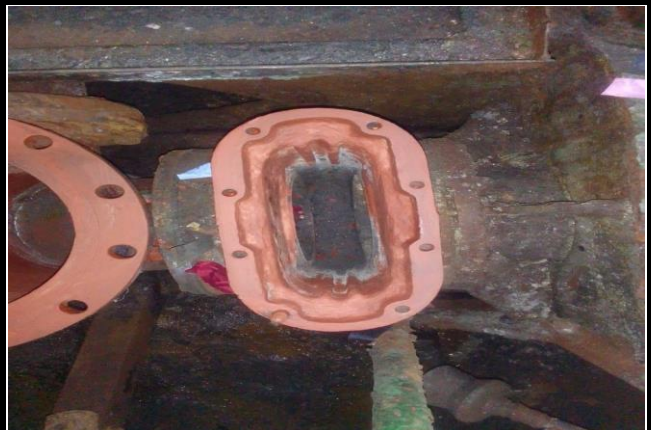
Kondisi saat dilakukan pekerjaan
