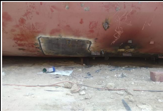
Kondisi saat dilakukan pekerjaan
