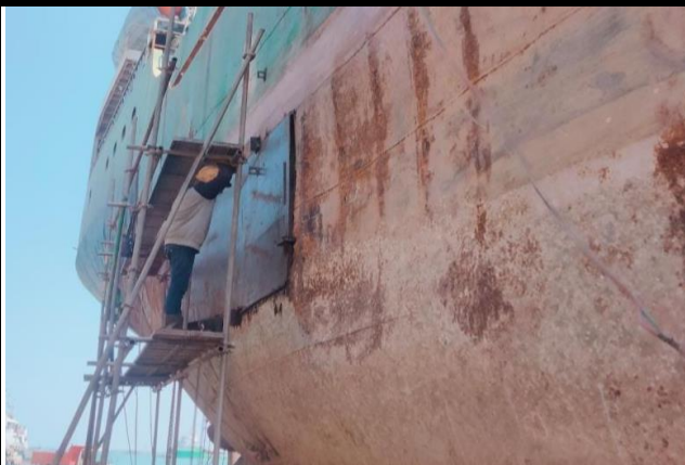
Kondisi saat dilakukan pekerjaan
