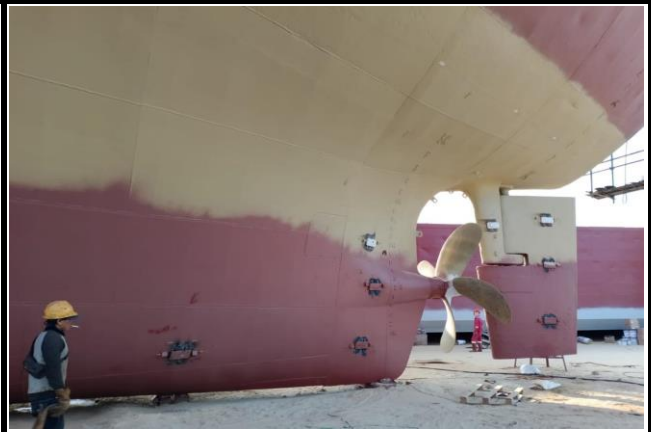
Kondisi selesai dilakukan pekerjaan
