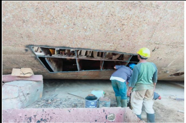
Kondisi saat dilakukan pekerjaan
