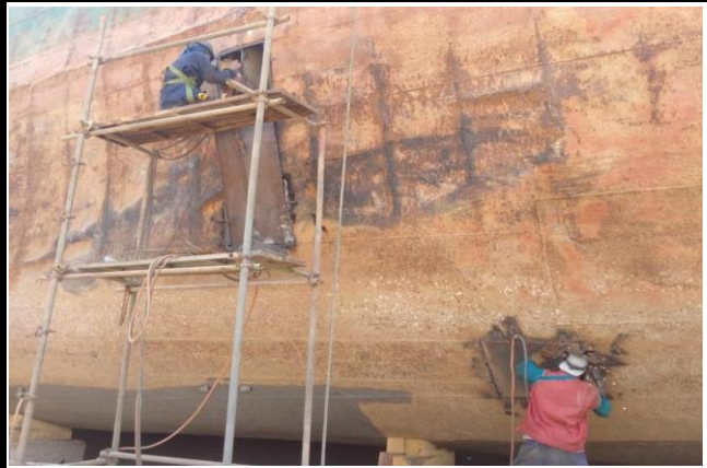
Kondisi saat dilakukan pekerjaan
