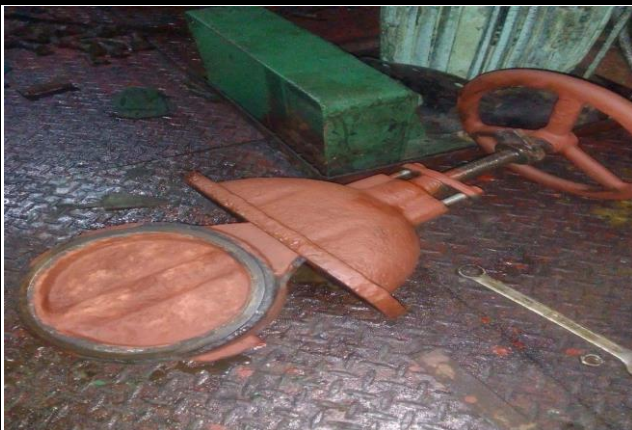
Kondisi saat dilakukan pekerjaan
