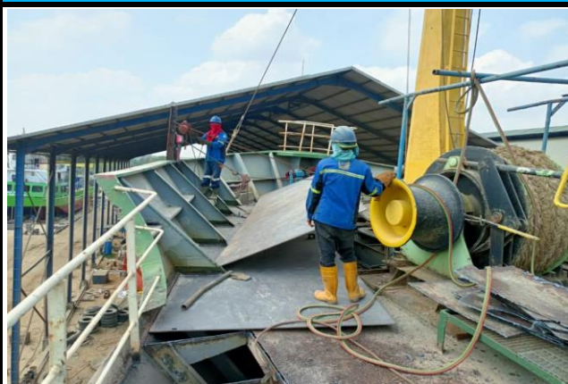
Kondisi saat dilakukan pekerjaan
